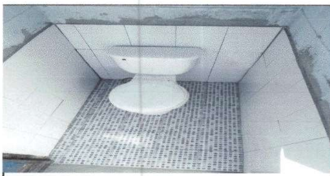
Foto 6: Sustitución de Inodoro
