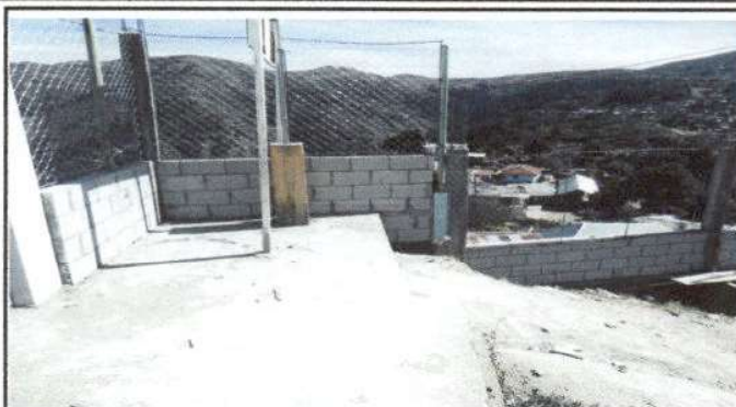
Foto 1: REPARACION DE MURO PERIMETRAL 14 METROS
