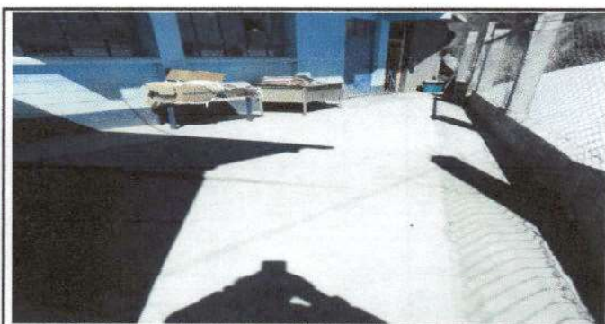
SUSTITUCIÓN DE PISO DE TIERRA POR TORTA DE CONCRETO DE PATIO
