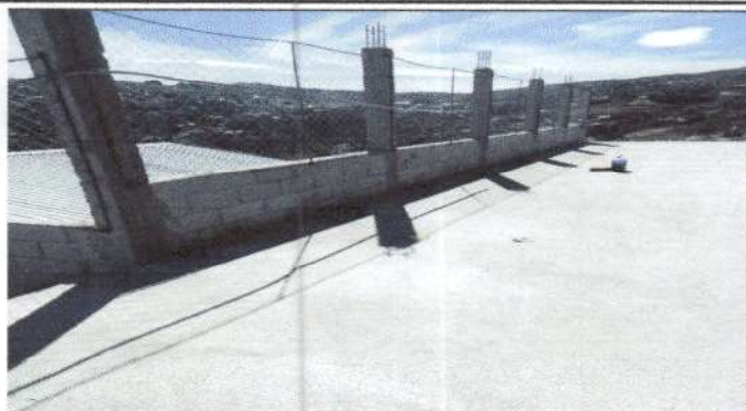
Foto 2: REPARACION DE MURO PERIMETRAL 14 METROS
